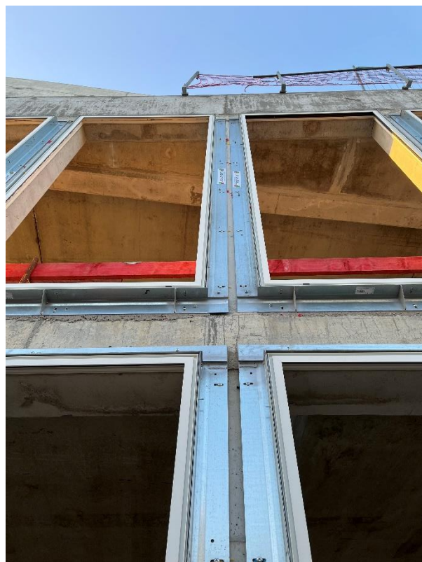
Médiathèque à Mareuil-sur-Lay-Dissais (85) - Crédit photo LOUINEAU Maître d'ouvrage : CC Sud Vendée Littoral (85) - Agence d'architecture : BASALT Architecture - Entreprise de pose : ALUMIVER
