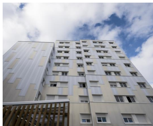
Après les travaux Crédit photos Cyril BADET - LOUINEAU
